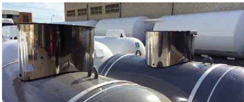
ARQUETAS DEPÓSITOS ENTERRADOS
